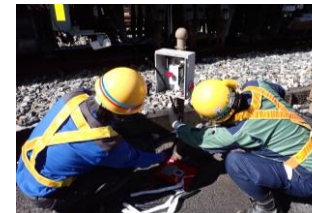
踏切設備の復旧
