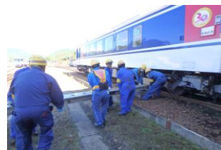
車両脱線復旧
