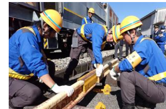
レールの復旧
