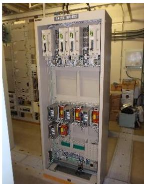
※符号処理器とは、信号機の状態など、列車に伝える運転条件を生成する装置
