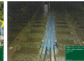
分岐器レール更换 (施工後)
