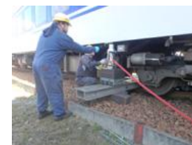
車両脱線復旧
