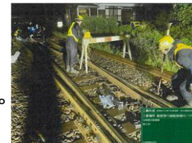
分岐器レール更换 (施工中)
