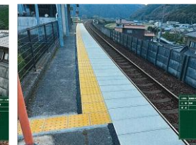
ホーム修繕（施工後）
