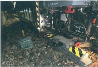
・マルチプルタイタンパーによる道床のつき固め
