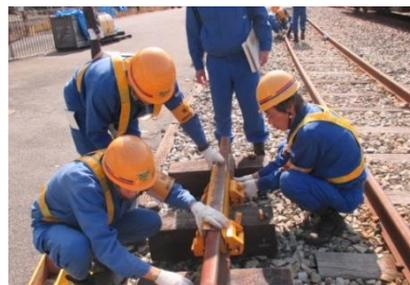
・施設課社員によるレール破断応急処置
