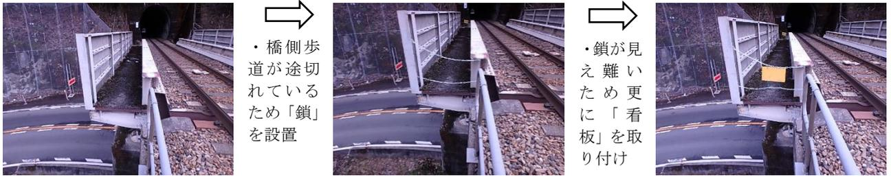
これを受けて、直ちに施設課社員が同一の橋側歩道のある橋梁 1・架道橋 2 箇所を調査し、他の箇所は鎖の設置を確認すると共に両端に「危険」看板を取付けた
