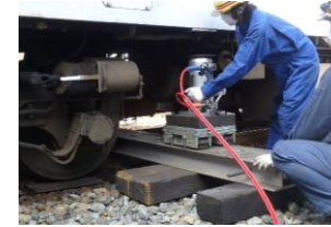
車両脱線復旧
