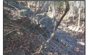
ロープネット工完了後
