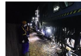
土床の突き固め
