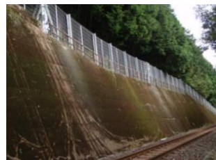
落石防護柵新設
