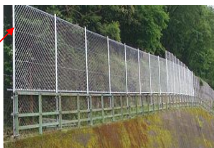
【落石防護柵新設(84m) 平成28年2月29日 佐用駅～石井駅間】
