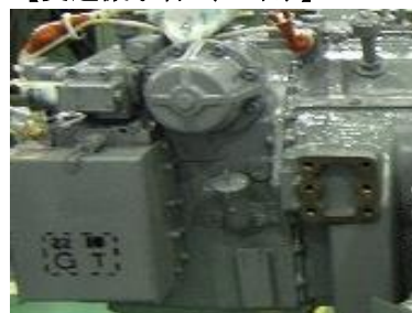
【変速機取替（22 台）】
